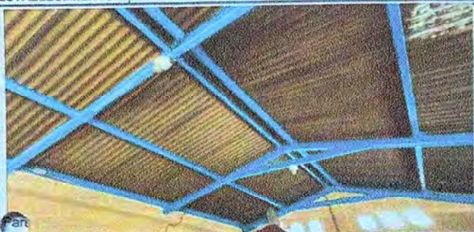
Fotografía 1: Mantenimiento a estructura de metal en la cocina.
