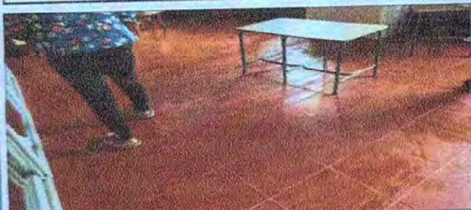
Fotografía 3: Instalacion de piso ceramico en cocina.
