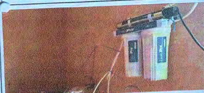
Fotografía 5: Instalacion de filtro de agua.
