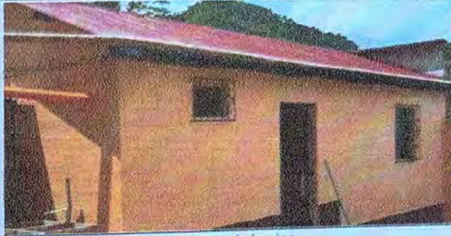
Fotografía 2: Pintura de cubierta de lamina.
